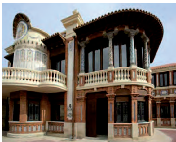
Fig. 5. Casa Solans, en Zaragoza, edificio modernista restaurado y reinaugurado en 2006. Hoy sede provisional del Secretariado del Agua de la ONU, es el único elemento que queda del antiguo complejo fabril de la harinera Solans.
