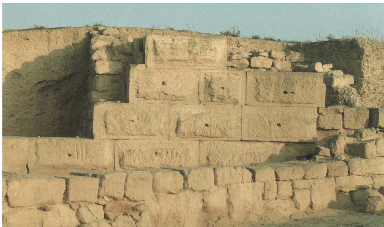
Figura 6. Paramento occidental del edificio romano dispuesto sobre los muros de las viviendas ibéricas, U1 y U2.
