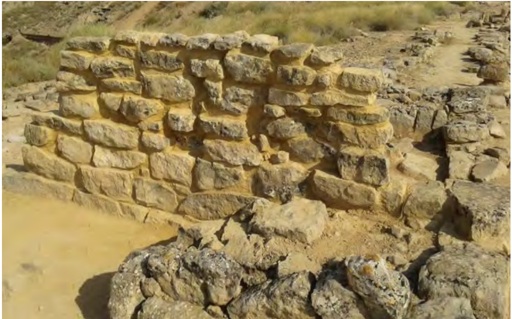
Figura 5. Resultado de la intervención en el muro caído y reconstruido por anastilosis. Paramento sur. Autor: David Rodríguez.
