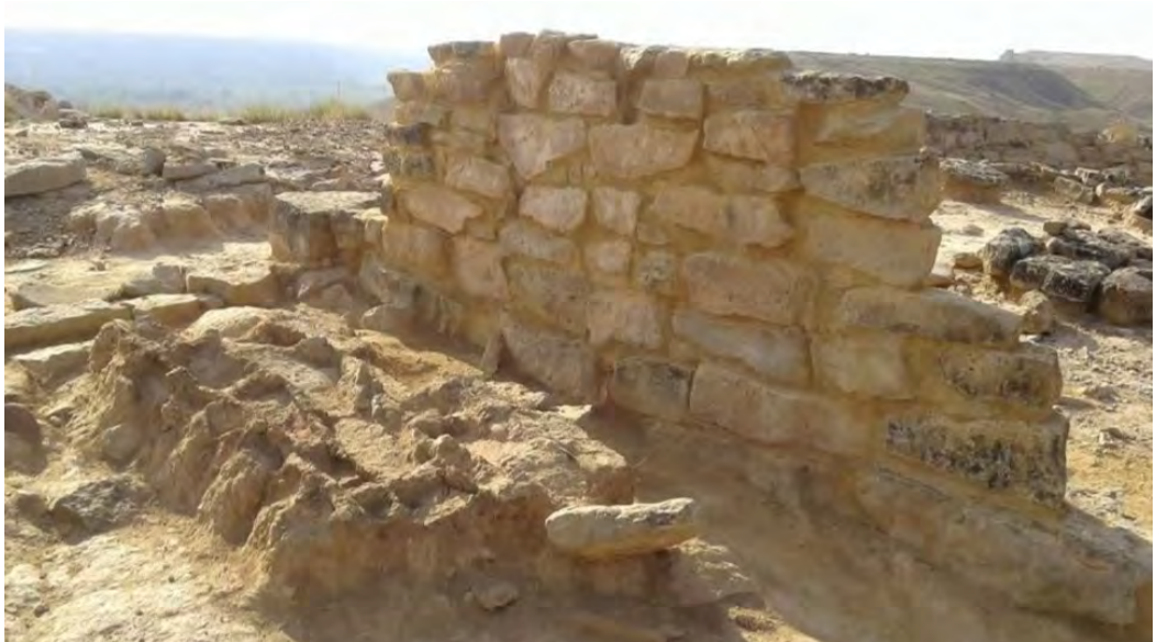
Figura 4. Resultado de la intervención en el muro caído y reconstruido por anastilosis. Paramento norte. Autor: David Rodríguez.
