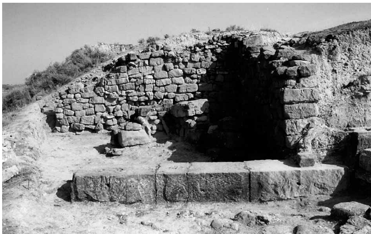
Figura 3. Vista parcial de dos de los muros en opus vittatum adosados al paramento en opus quadratum , en la ladera oriental, antes de la consolidación.
