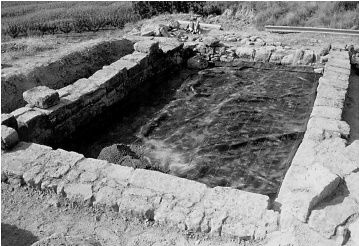
Figura 6. Colocación de los geotextiles sobre los pavimentos de tierra batida y cal de las viviendas ibéricas.
